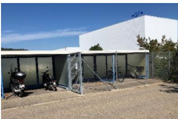
Veloparkplätze in einer abschliessbaren, überdachten Anlage für Mitarbeitende.
