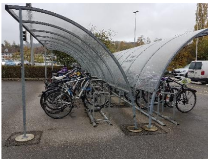
Überdachte Parkplätze mit Anschlussvorrichtung
